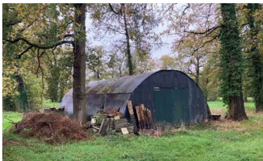
Afbeelding 10. Te saneren bebouwing en mestkelder
