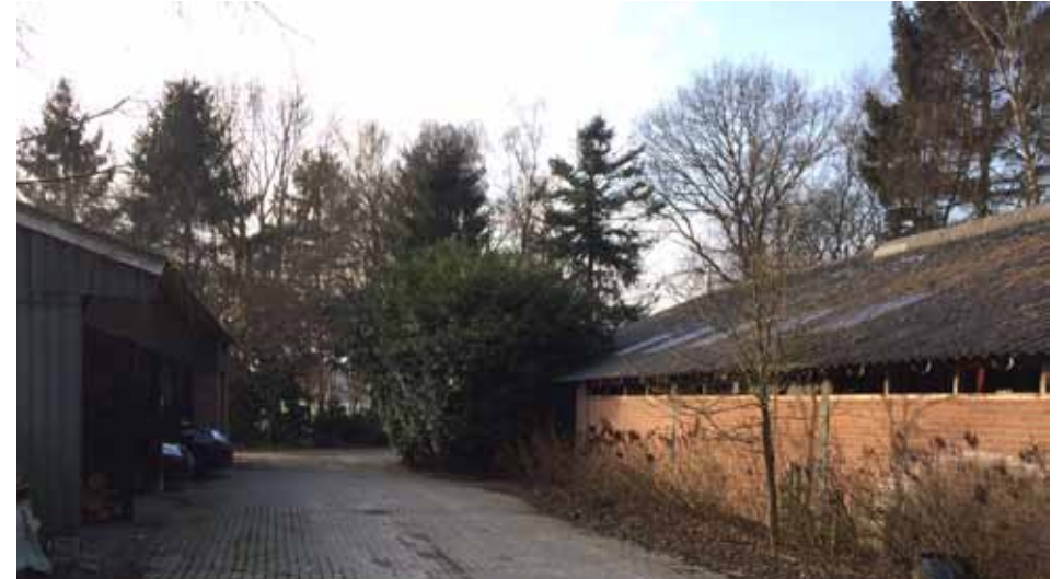
Afbeelding 22. Te slopen schuren
