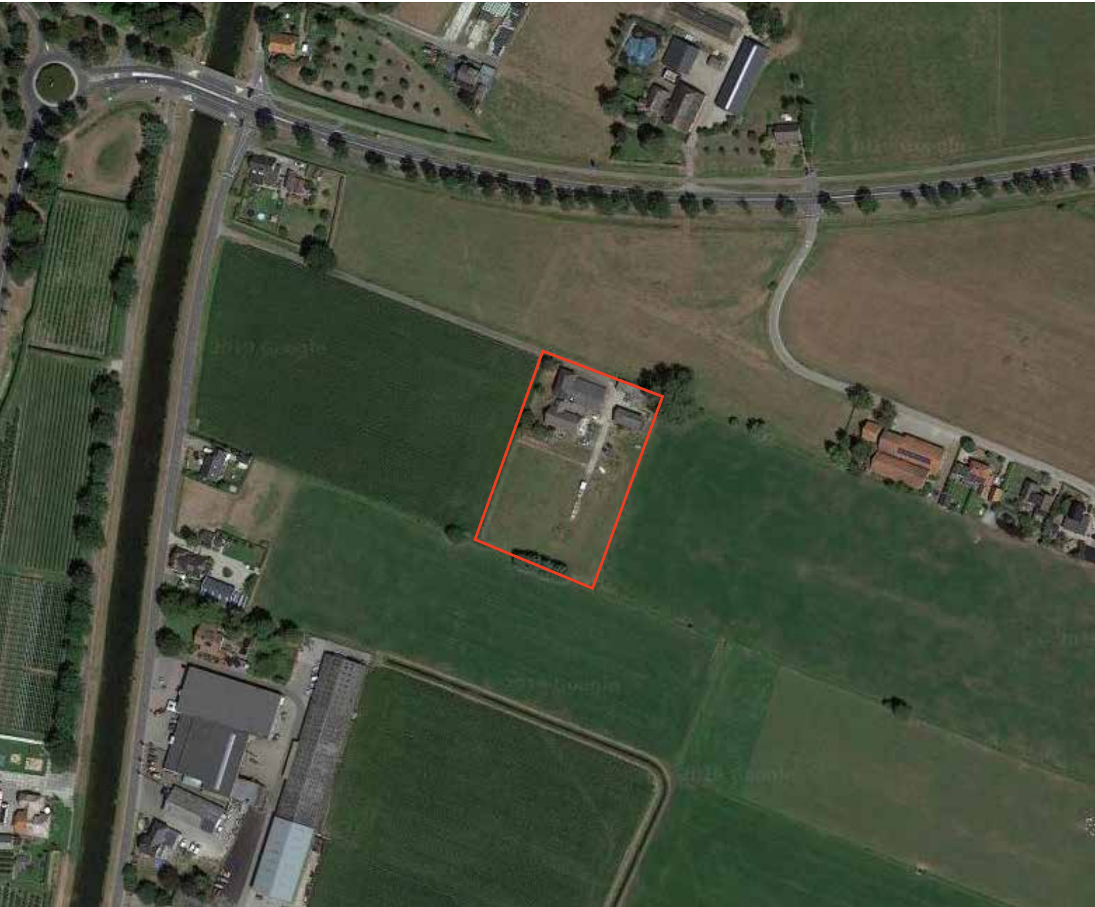
Luchtfoto met daarop de locatie (bron: Google Maps)
