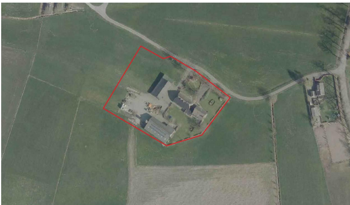
Figuur 2: Luchtfoto van het erf Wellenberg 2 en de directe omgeving
