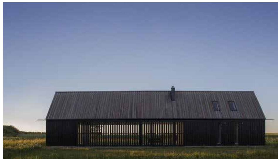
Afbeelding 23. Ramen zijn deels aan het zicht onttrokken, waardoor een schuurachtig karakter ontstaat.
