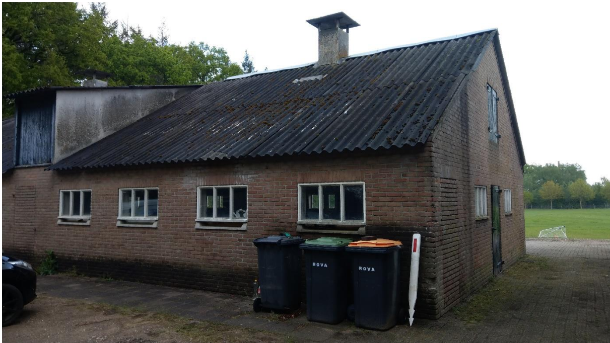
Figuur 2: Beeld van een deel van de te slopen varkensschuur (situatie 2 mei 2020).
