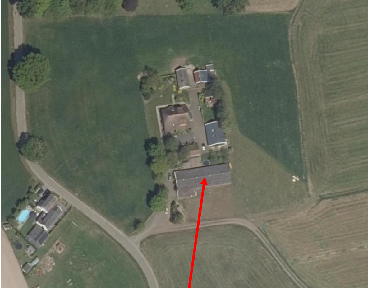
Geheel te slopen schuur geduid met rode pijl
