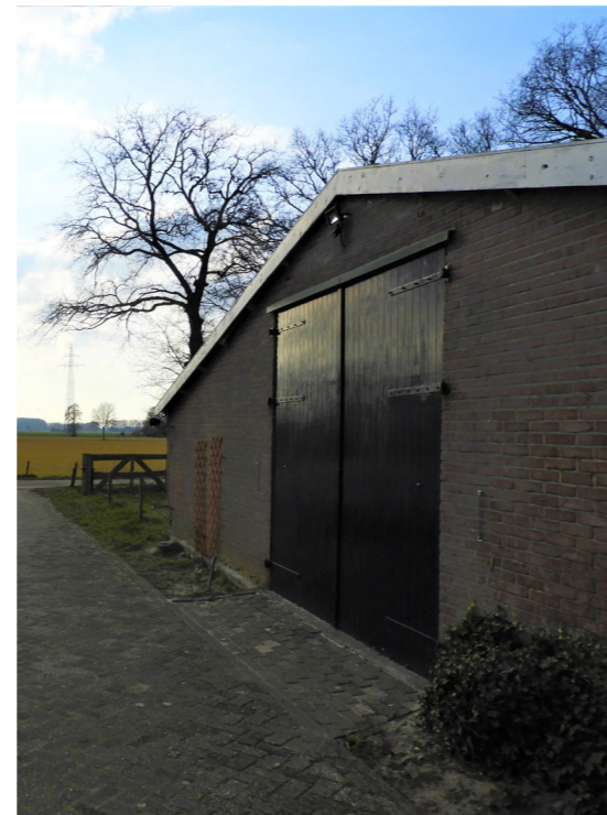
Te slopen kippenhuur.
