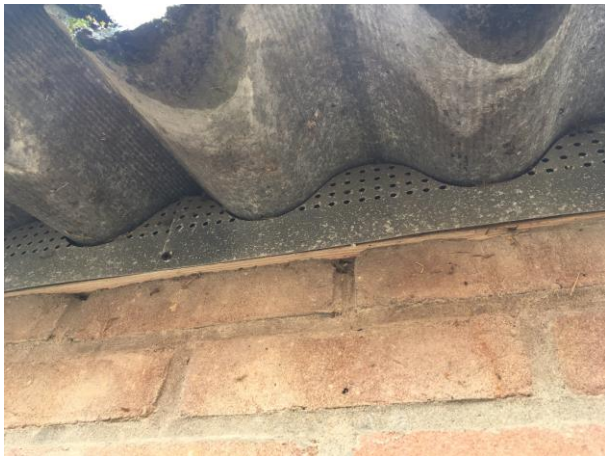
Een metalen strip weerhoudt vogels en zoogdieren een verblijfplaats te betrekken onder de golfplaten.
