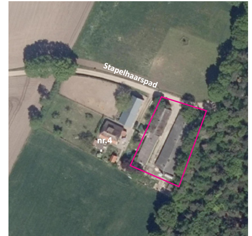
Plangebied erfontwikkeling waarbij de te slopen gebouwen nog zichtbaar zijn.
