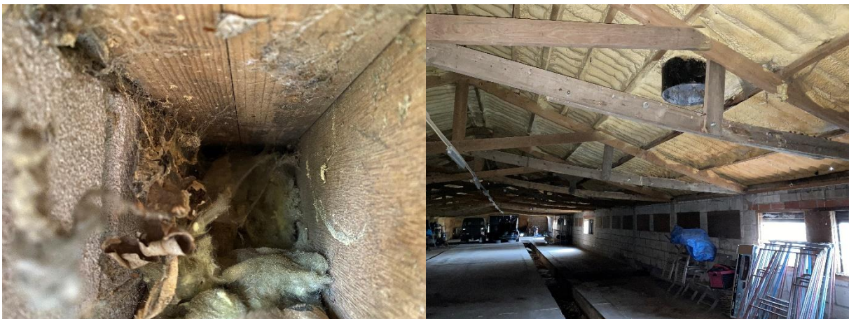
Afbeelding 9. Volledige dichte spouw (links) en dak zonder dakbeschot (rechts).
