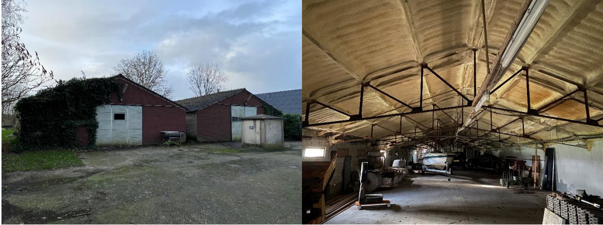
Afbeelding 3. De voorzijde van de te slopen stallen (links) en de binnenzijde van de meest oostelijke stal (rechts).
