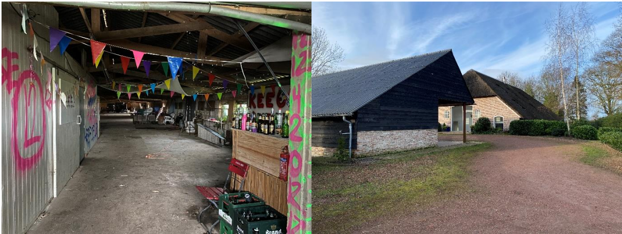
Afbeelding 4. De binnenzijde van de meest westelijk stal (links) en de recentelijk gerenoveerde woning en kapschuur (rechts).
