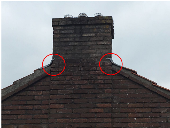
Kopgevel met invliegopeningen bij daklood rood omcirkeld.
