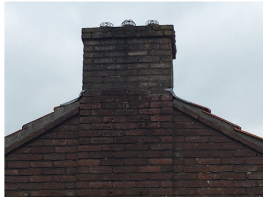
Indrukken van de daken; links een scheve dakpan en rechts een kopgevel met schoorsteen en loodslabben.
