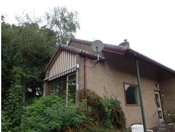
Foto 1: links, Zuidzijde woning met gevelbetimmering en afgedichte kantpannen.
