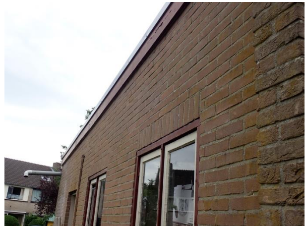
Foto 6: rechts, het strak aangebrachte dak overstek. De bitumen zijn op de zichtbare planken gebrand.
