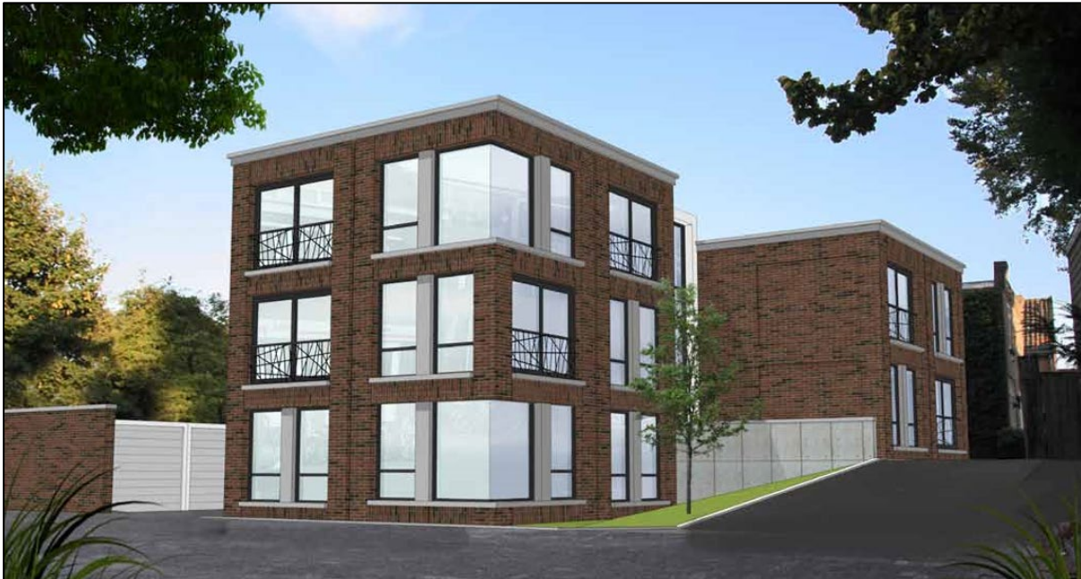
Zicht vanaf de hoek kippenmarkt, tegenover de fietswinkel. Het hoogteverschil in het plangebied is goed zichtbaar. Bron: Morphique architecten.
