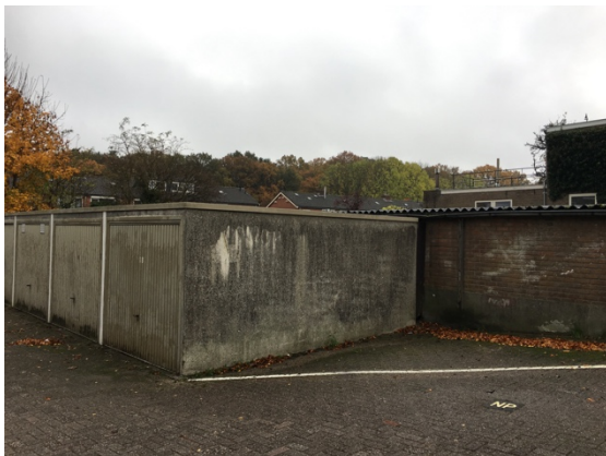
Afb. 3.7. Links: voor- en zijkant te verplaatsen garageboxen, Rechts (stenen muur): te amoveren garageboxen.
