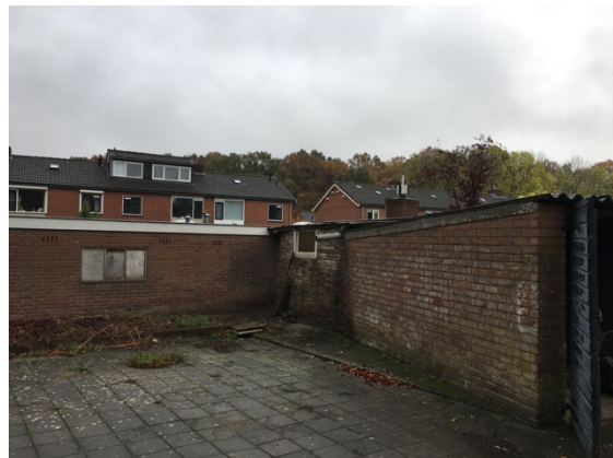
Afb. 3.6. Achterzijde te behouden garageboxen, Tegen deze achterzijde worden de boxen geplaatst.
