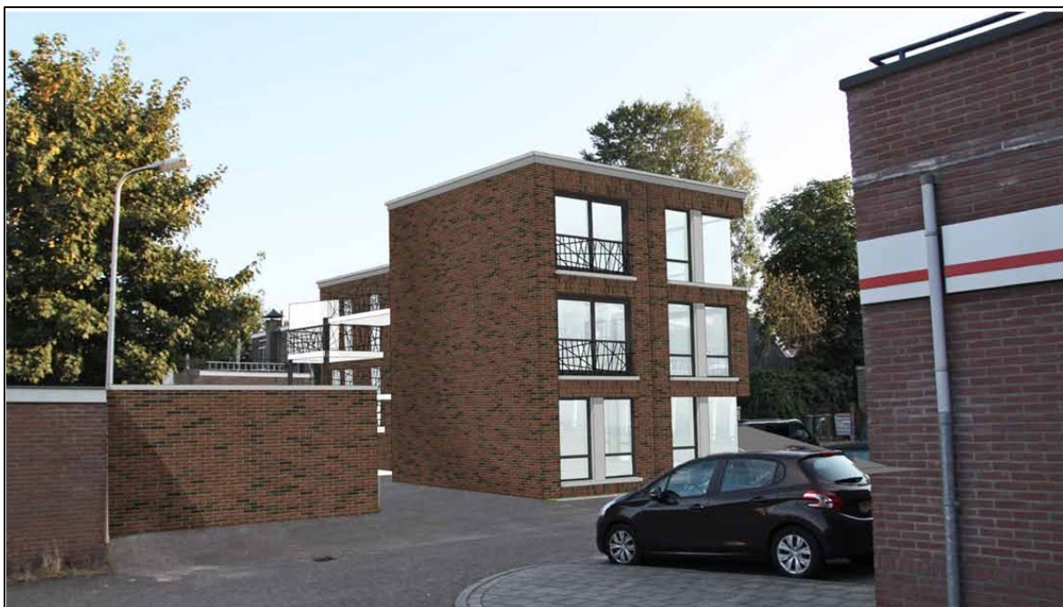
Zicht vanaf de toegang via de Torenstraat. Bron: Morphique architecten.
