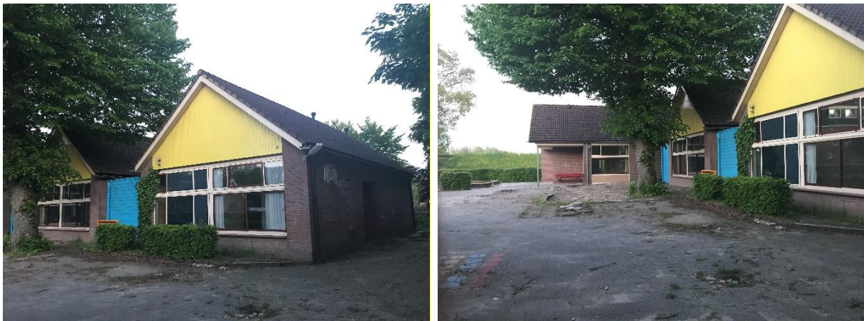
Afbeelding 3a. Impressie voorzijde schoolgebouw opgetrokken uit dakpannen en b. Het schoolgebouw met de oude linde en enkele hagen op het verharde schoolplein.
