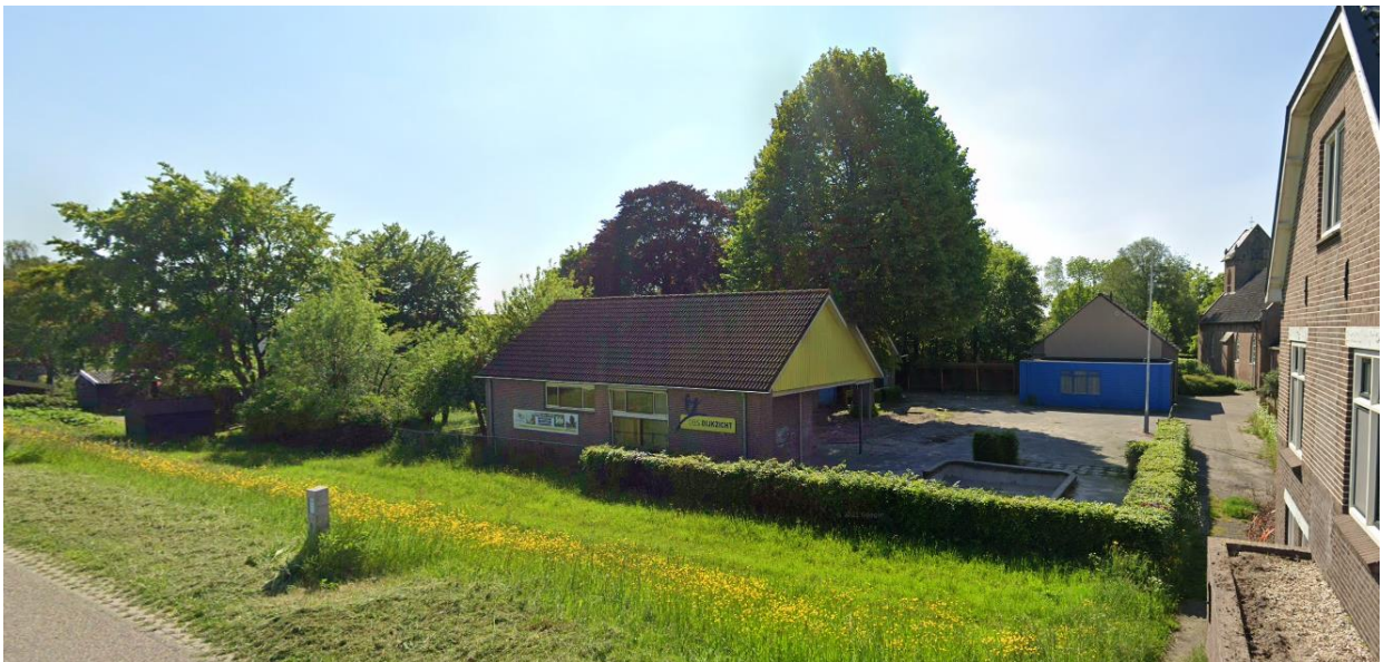
Afbeelding 5. Aanzicht op het schoolgebouw en de kazerne vanaf de IJsseldijk (Google Street View, mei 2021).
