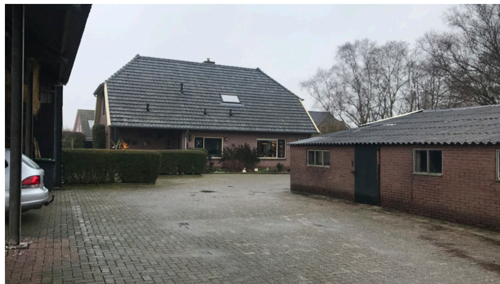
Te behouden woonhuis in het midden. Links en rechts de te slopen bijgebouwen.
