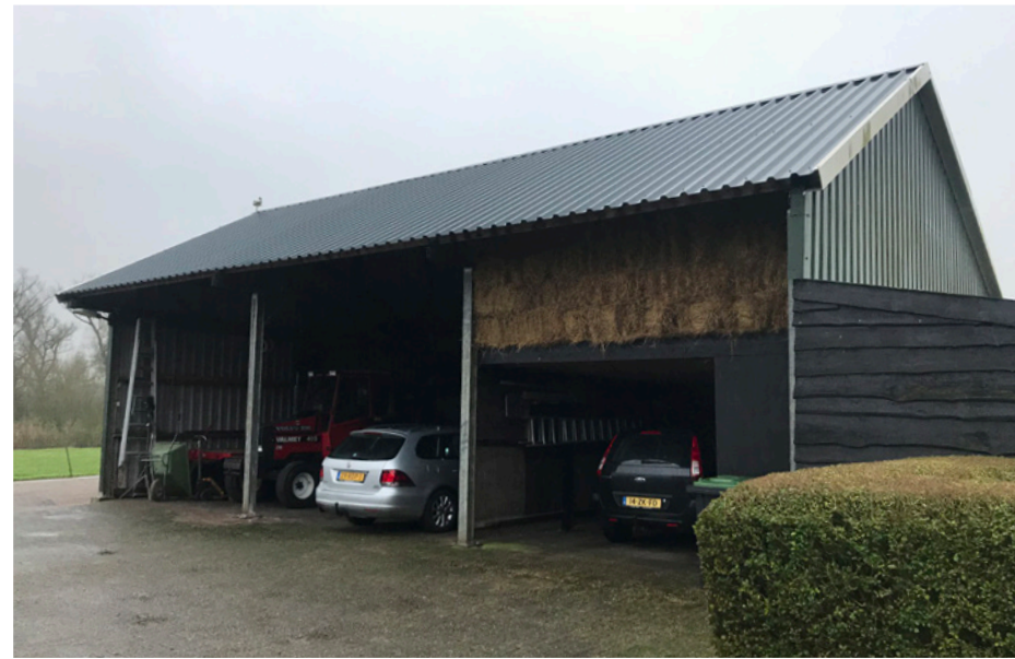
Te slopen kapschuur.
