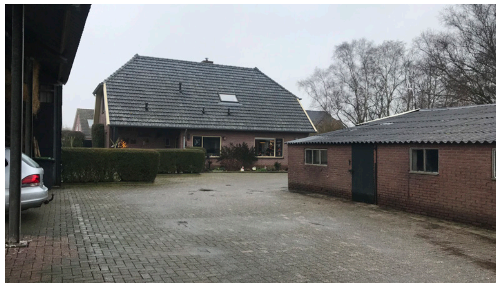
Te behouden woonhuis in het midden. Links en rechts de te slopen bijgebouwen.
