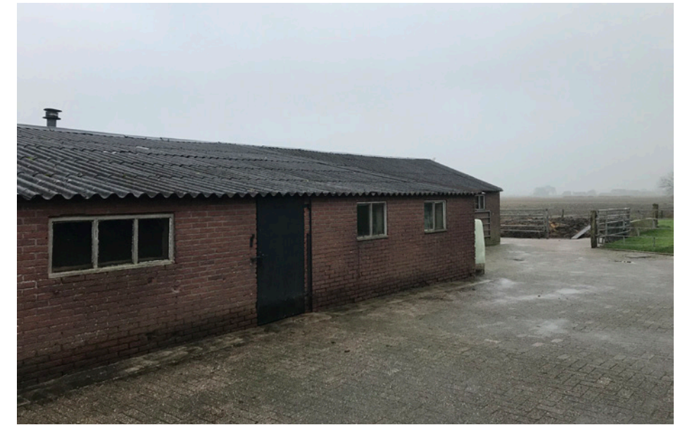
Te slopen schuur met asbestdak.
