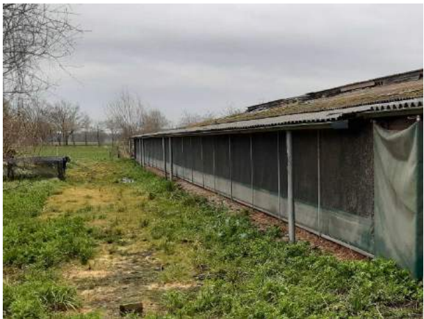
Dakgoot overkapping noordzijde schuur
