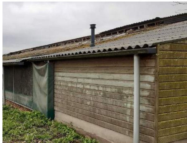
Dakgoot uitbreiding kippenshuur 2010
