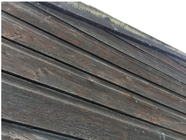
De planken sluiten strak aan op elkaar en bieden geen verblijfplaats voor vleermuizen.
