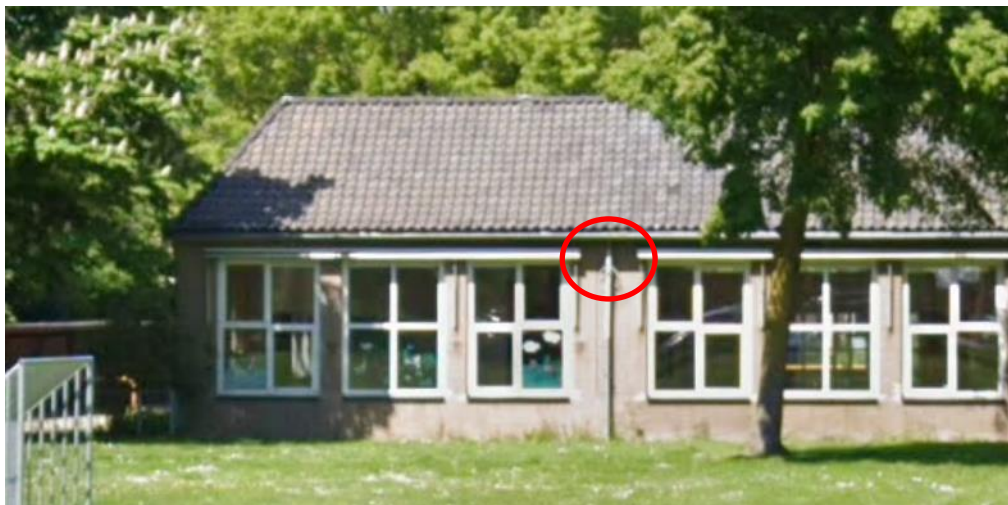
Figuur 4.1 Aangetroffen verblijfplaats gewone dwergvleermuis toegankelijk via open stootvoeg achter regenpijp (rood omcirkeld). Bron foto: Google Maps.
