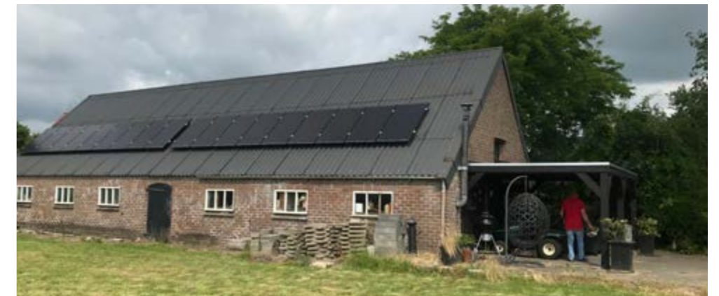
Te slopen schuur.
