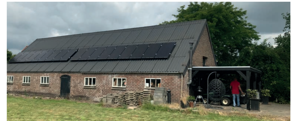
Te slopen schuur.
