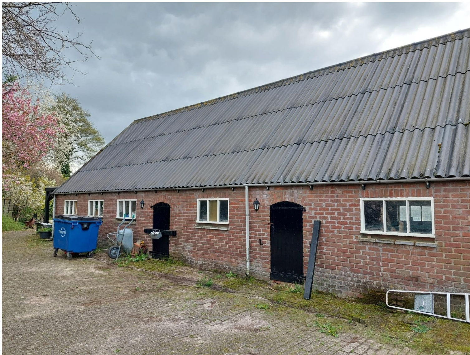
Afbeelding 3: Buitenaanzicht van de te verwijderen schuur, situatie op 26 april 2023.
