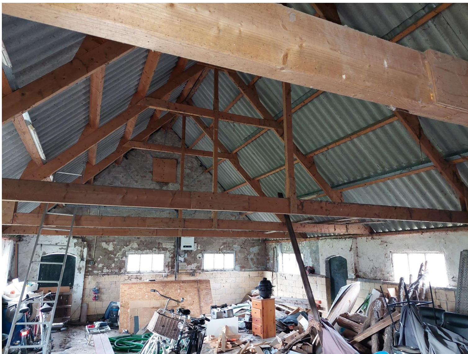
Afbeelding 4: Binnenaanzicht van de te verwijderen schuur, situatie op 26 april 2023.
