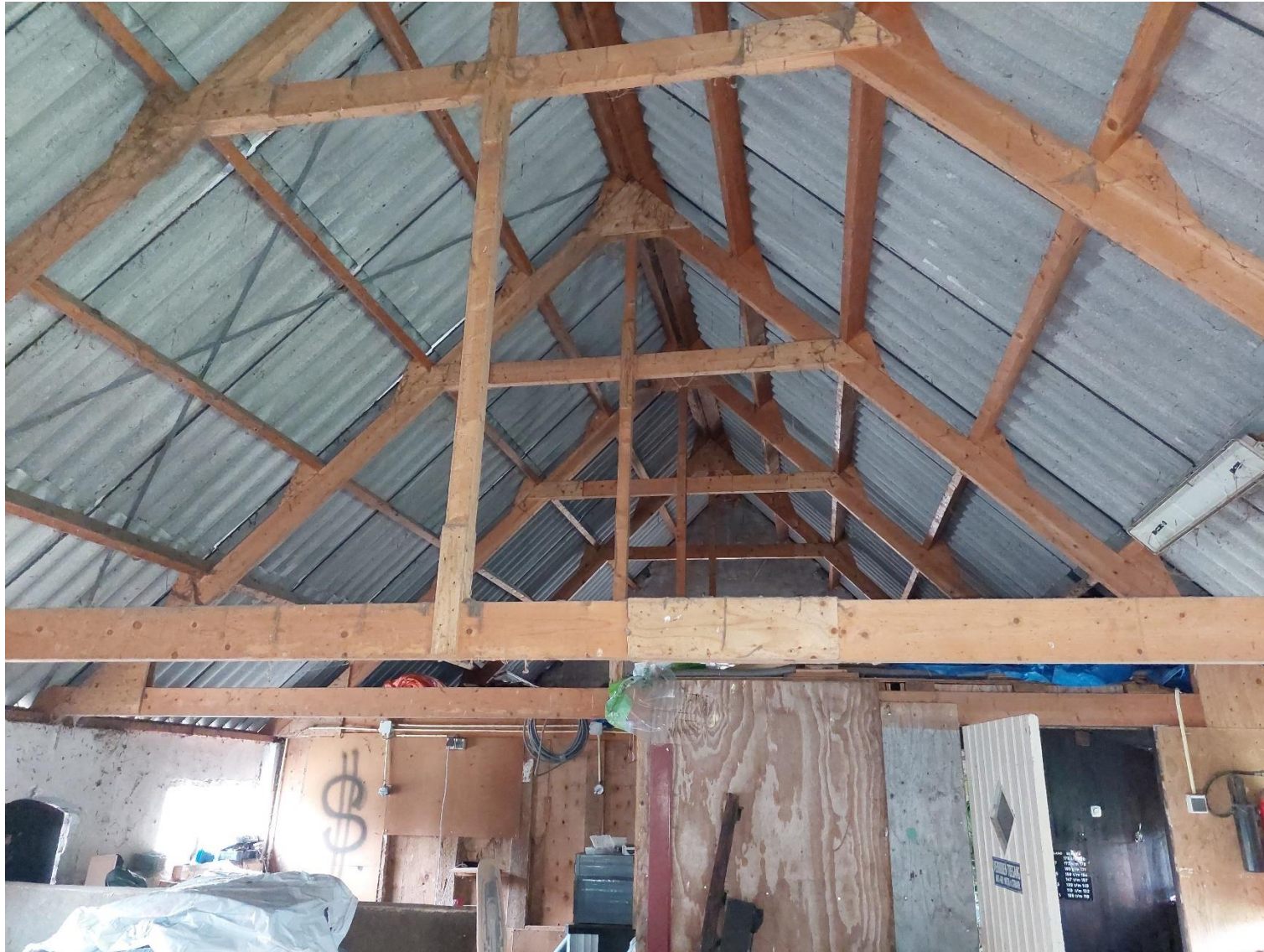
Afbeelding 5: Binnenaanzicht van de te verwijderen schuur, situatie op 26 april 2023.
