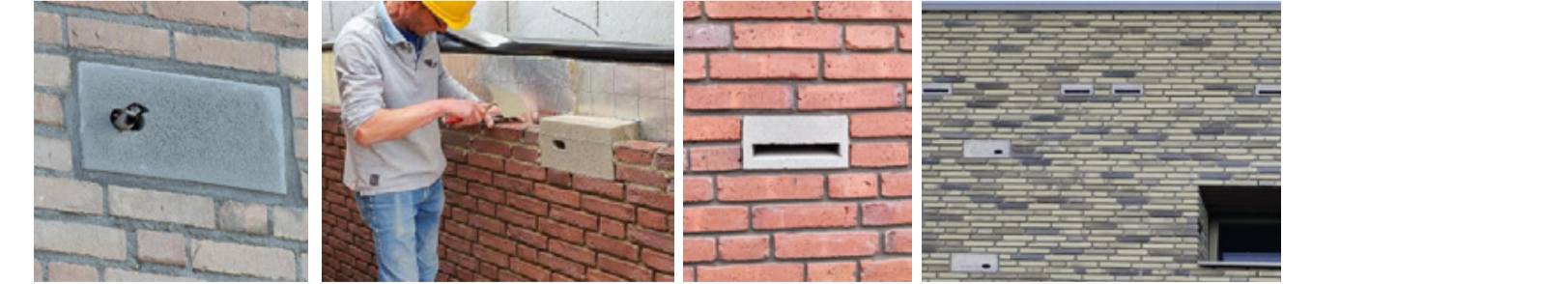
In de gevels inbouw nestmogelijkheden opnemen voor vogels (koele zijde) en voor vleermuizen (warme zijde).
