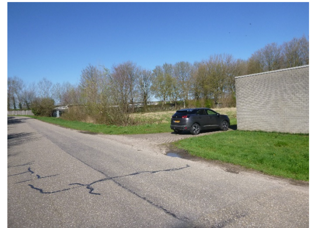
Rioolgemaal aan de Jan Meesterweg 15
