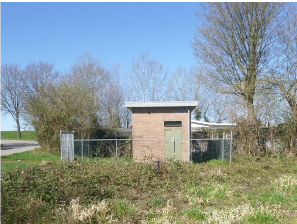
Transformatorhuisje aan de Jan Meesterweg 15T
