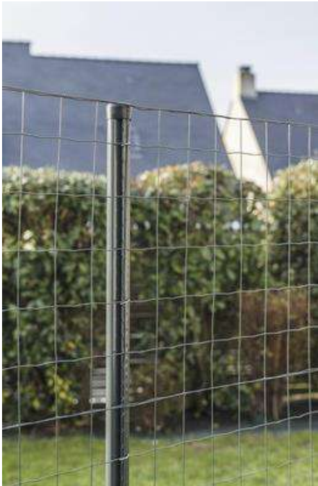
Figuur 6 Voorbeeld 10 cm x 10 cm vierkant gaas hekwerk Zonnepark Daslever (Bron: Google)
