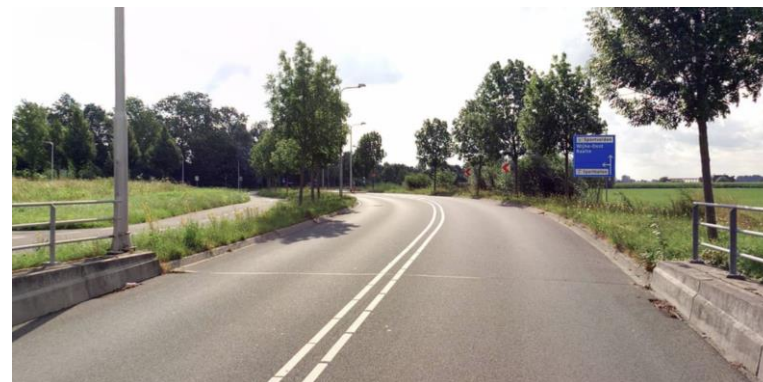
Figuur 3.2: huidig zicht vanuit de tunnel op het kruispunt Omloop – De Lange Slagen
