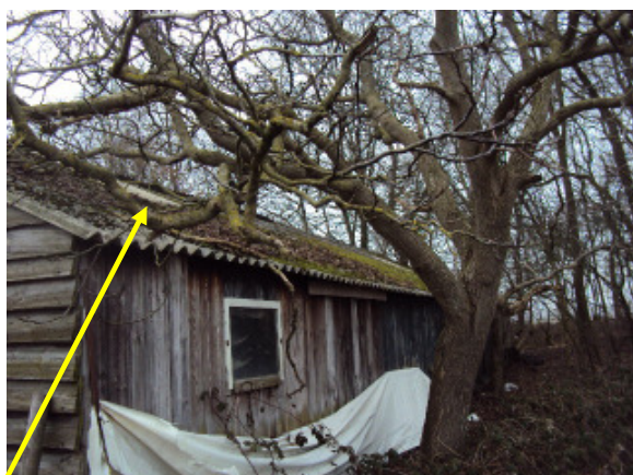
Afbeelding 5: Buitenzijde schuur/Golfplaten op het dak
