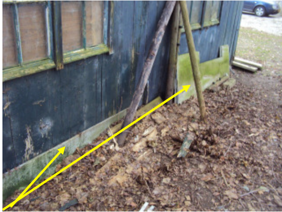
Afbeelding 7: Buitenzijde schuur/Losse schotten
