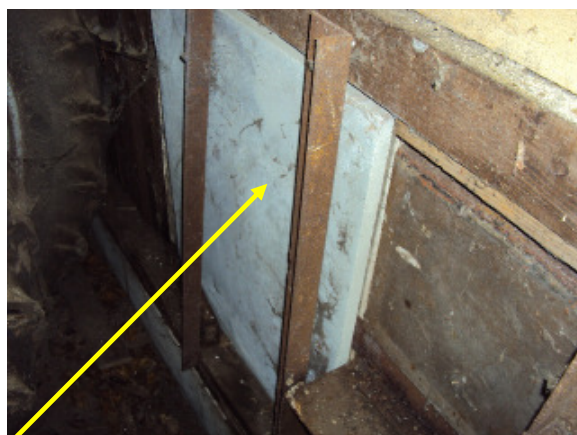
Afbeelding 6: Buitenzijde schuur/Losse schotten
