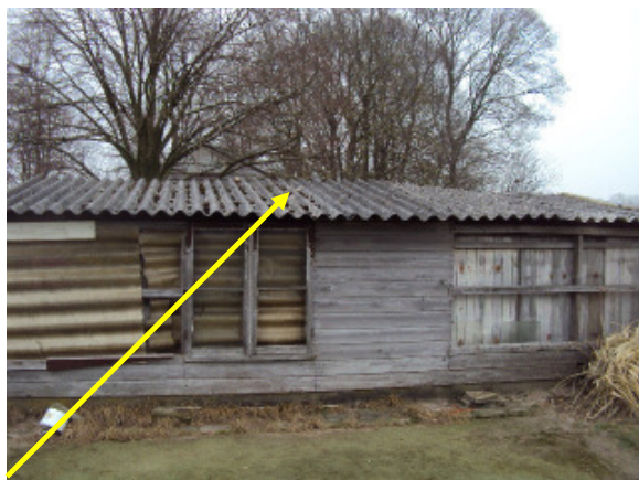
Afbeelding 3: Buitenzijde schuurtje/Golfplaten op het dak
