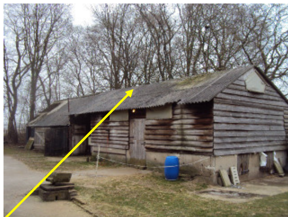
Afbeelding 4: Buitenzijde schuur/Golfplaten op het dak
