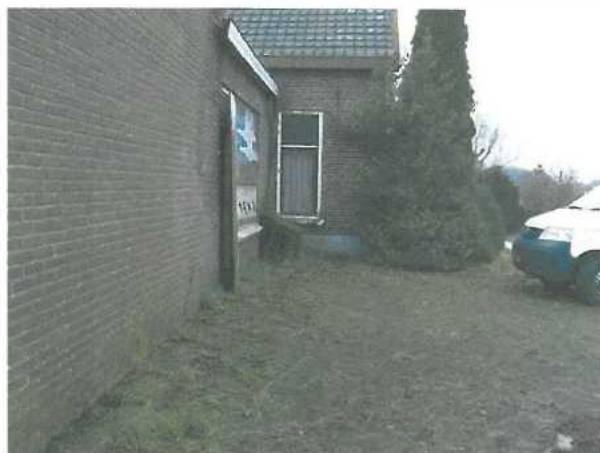
Foto 20: Voorgevel bestr. woning vanaf zijkant kavel
