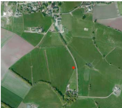
Figuur 2. Luchtfoto huidige situatie met voorgenomen locatie molenterrein.
