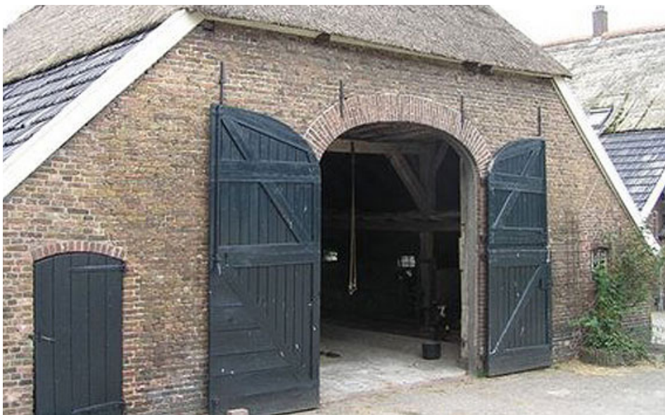
Afbeelding 50. Sallandse inspiratie: baanderdeuren in het midden van de gevel. Kleinere deuren aan de zijflanken van de gevel.
