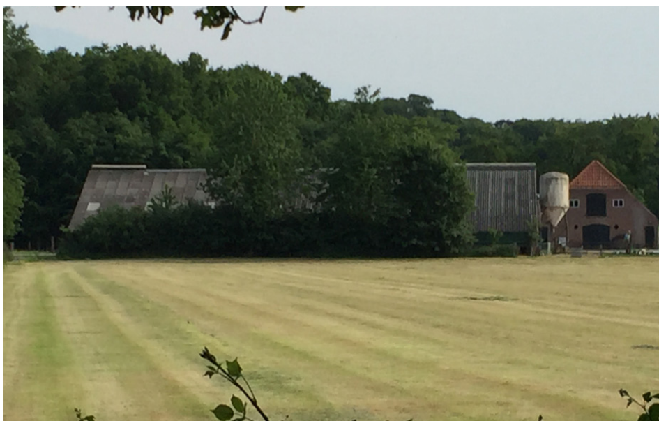
Afbeelding 47. Het erf, gezien vanaf het noorden. Rechts staat de bestaande woning. Het volume van de schuur is groot.
