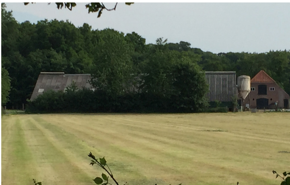
Afbeelding 47. Het erf, gezien vanaf het noorden. Rechts staat de bestaande woning. Het volume van de schuur is groot.
