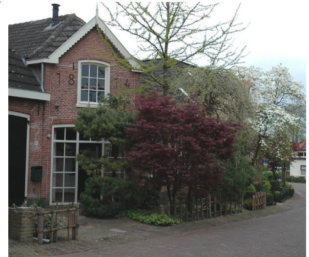
De voormalige smidse en het aangrenzende De (kromme) Jakke horen ook in het dorpsgezicht thuis, respectievelijk als waardevolle gevel en als waardevolle structuur.
