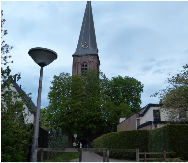
De plek van de afgebroken school biedt nu een mooi zicht op de kerk en het hoogteverschil met de omgeving.
