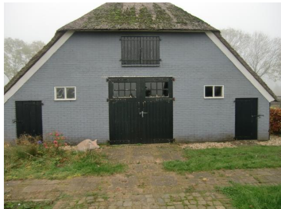
Foto bestaande achtergevel
