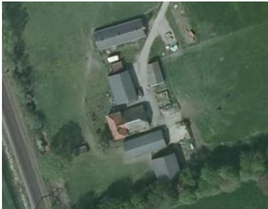
Overzicht erf aan Zandweteringspad 6 Olst
