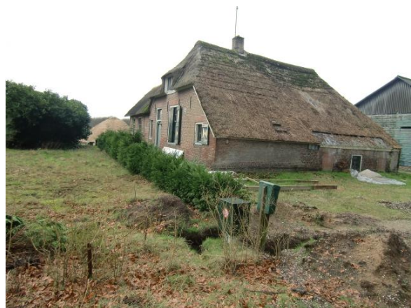
Bestaande boerderij, slopen en nieuwbouw
