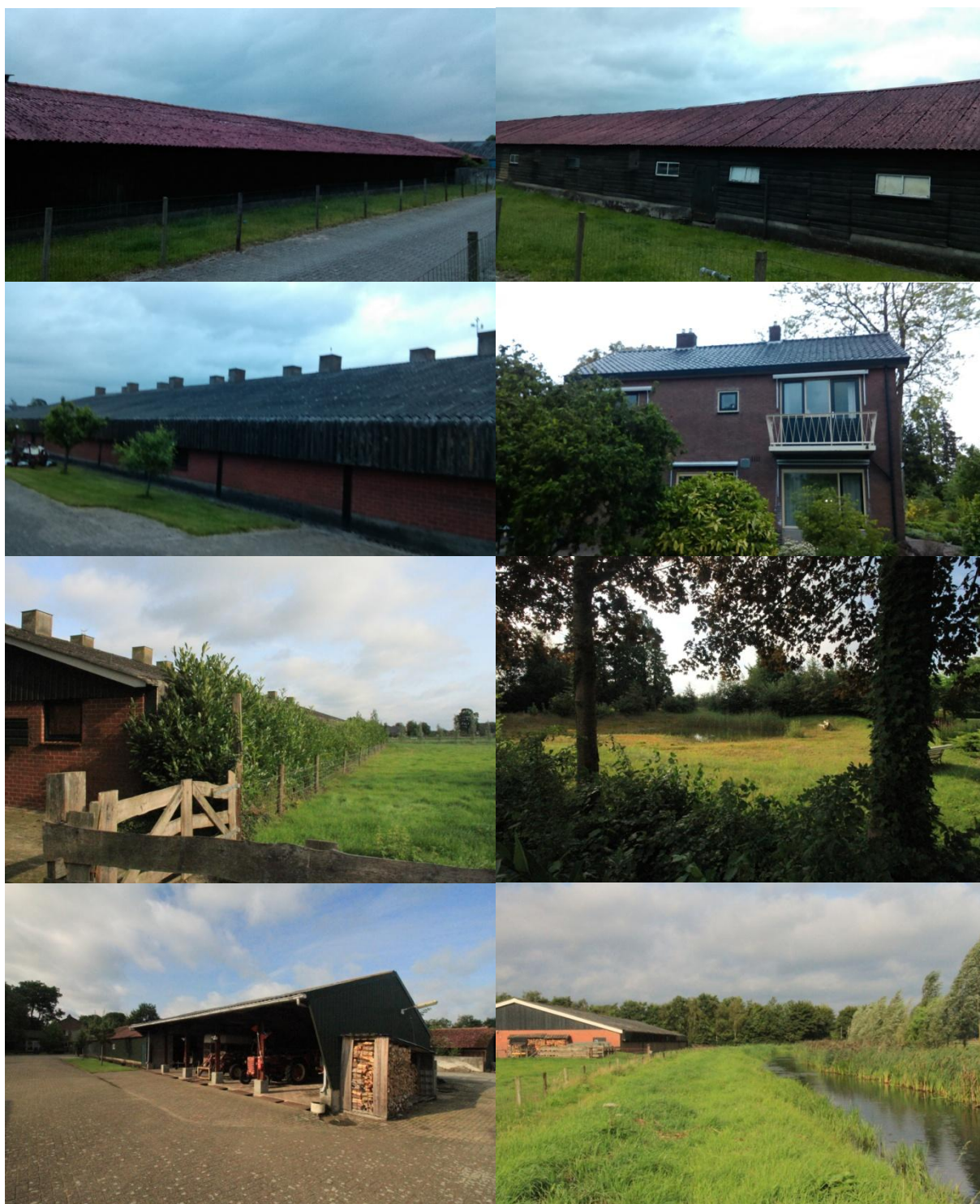
Figuur 2 sfeerimpressie van het plangebied met van links naar rechts en boven naar onder: Foto 1 & 2, voormalige kippenschuren, Foto 3: voormalige kippenschuur momenteel in gebruik als stalling voor caravans, foto 4: bestaande woning, foto 5: te verwijderen laurierhaag aan rand van het plangebied, foto 6: Amfibieën poel, foto 7: Werktuigenstalling, foto 8: Grote Vloedgraven langs de achterzijde van het plangebied.
