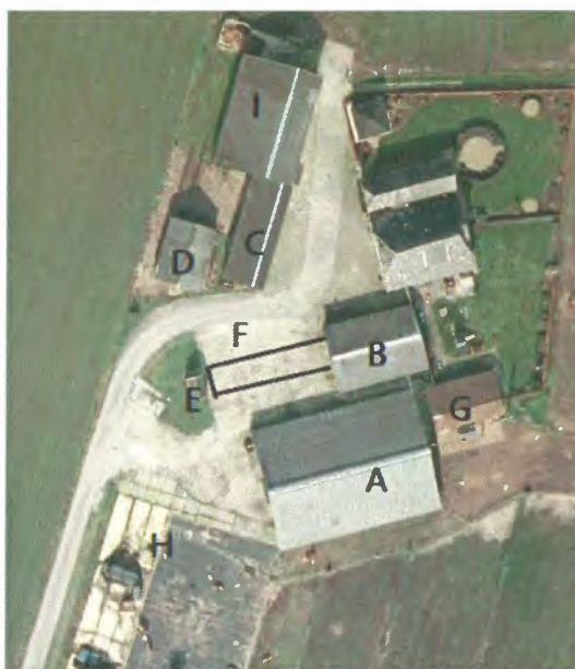
Overzicht te slopen schuren en te saneren putten en kuilvoerplaten
