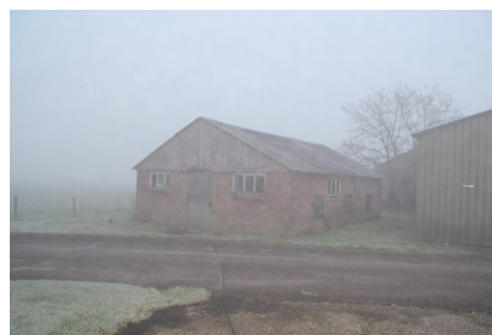
Figuur 6. Te slopen schuur (D).
