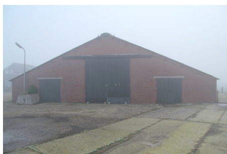
Figuur 3. Te slopen koeienstal (A).
