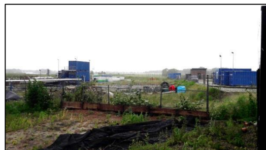
Figuur 2.3: Asfaltsanering noordelijk van de molen
