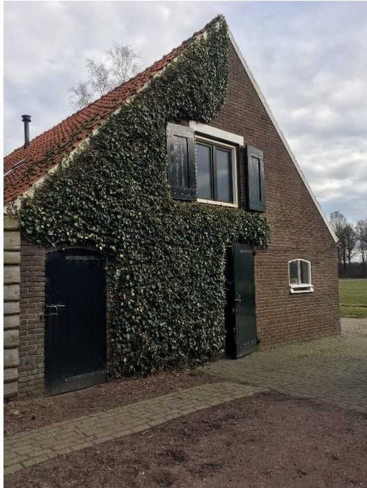
Zijaanzicht van de stenen kapschuur
