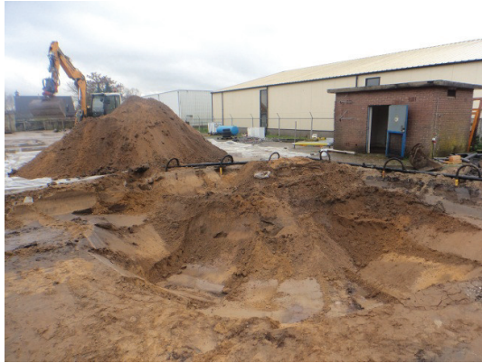
27-11 verwijderen toplaag deellocatie A
