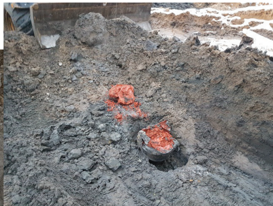
12-2 aantreffen stortmateriaal, voornamelijk verf
