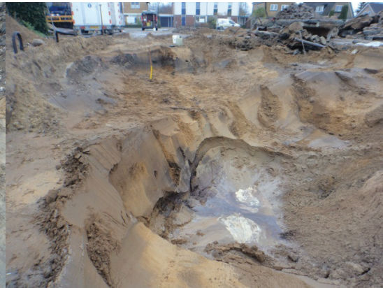
27-11 ontstaan van drijf laag met puur product
