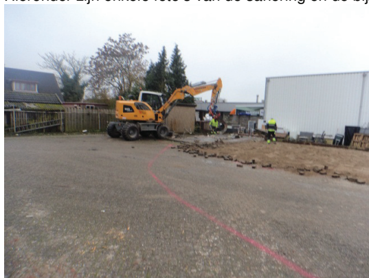
15-11 Verwijderen klinkers C
