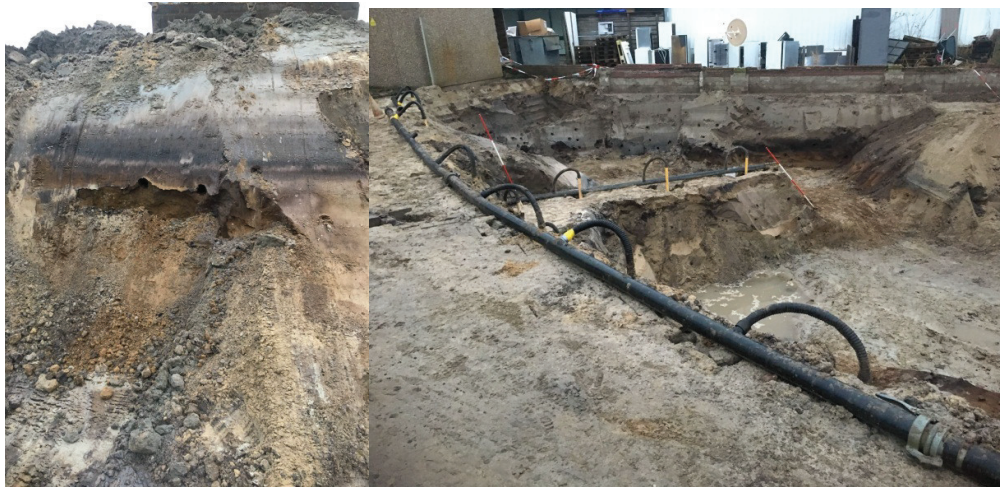
20-12 Wand met stortmateriaal
