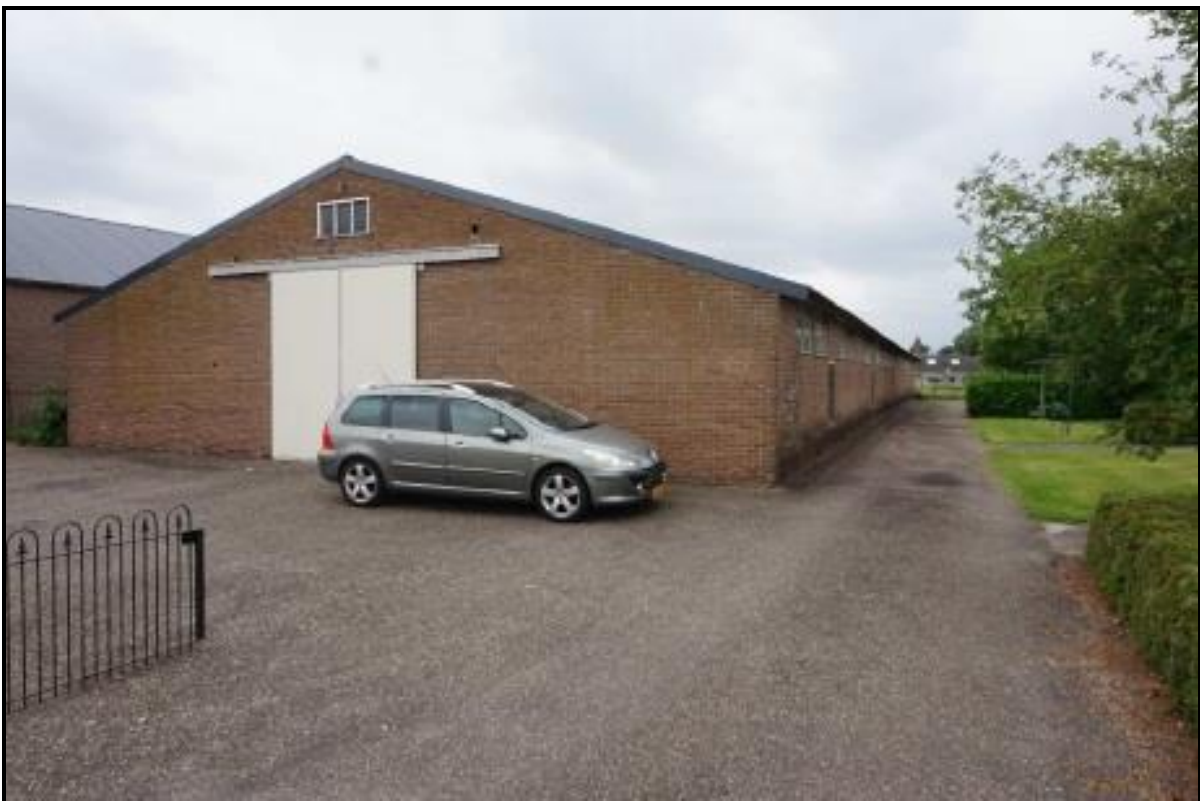
Foto zuidelijke schuur (caravanstalling) met omliggende asfaltverharding
