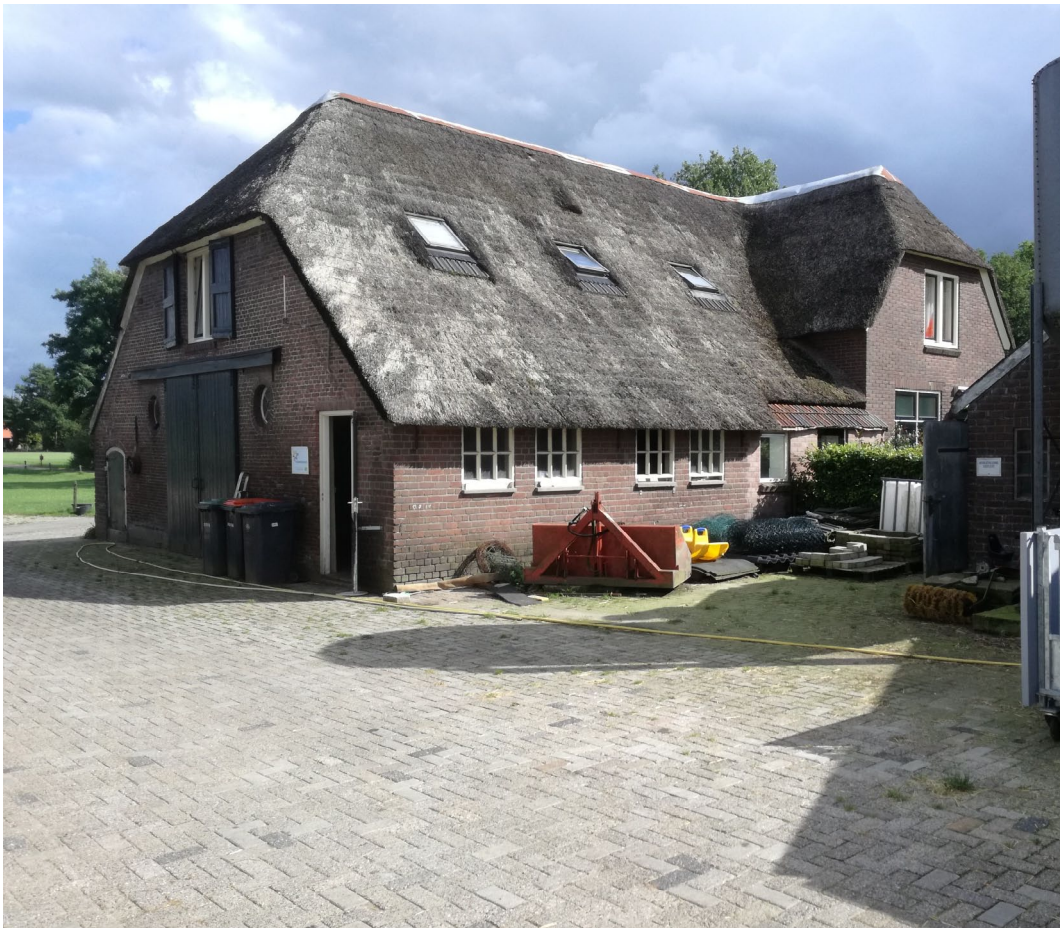
Afbeelding 10. Bestaande, te behouden boerderij
