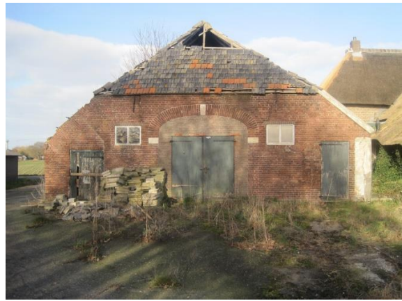
Foto, te slopen en her te bouwen schuur
