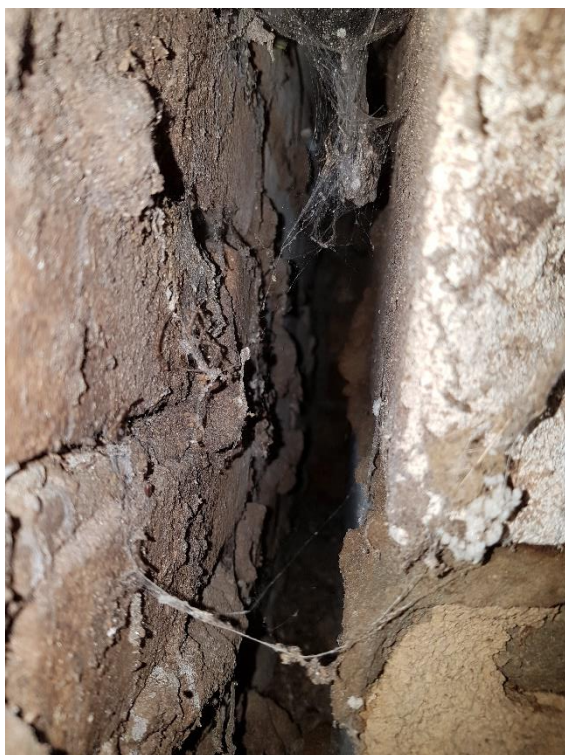
Figuur 10 (links): Opening in de spouwruimte van de naast de houtsingel gelegen varkensschuur.
