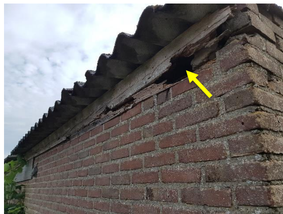
Figuur 10 (links): Opening in de spouwruimte van de naast de houtsingel gelegen varkensschuur.
