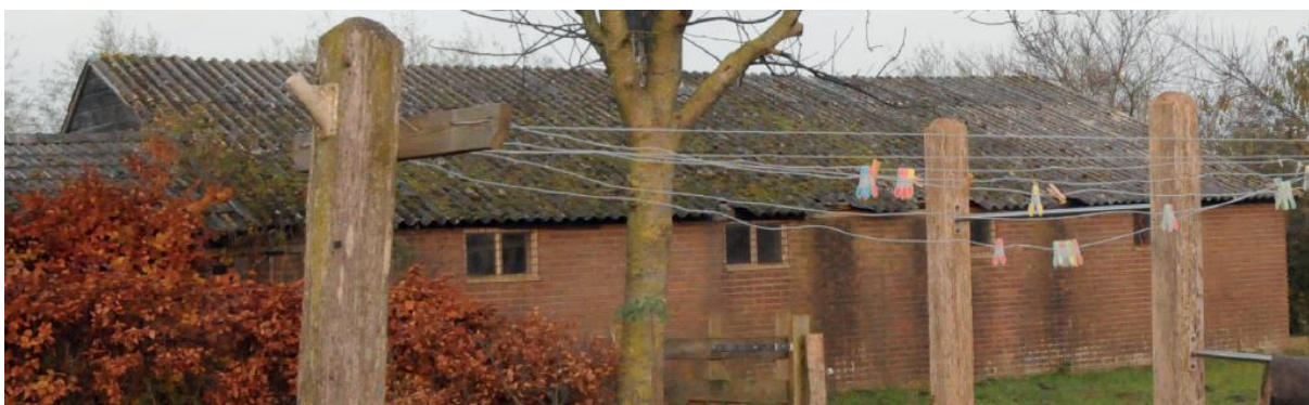
Figuur 6: Foto van de te slopen schuur aan de Raalterweg 25
