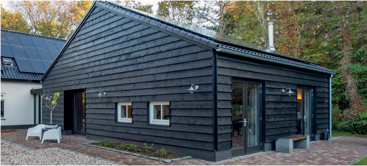
Afbeelding 17. Gepotdekselde donkere gevel, grijze dakpan en donkere zonnepanelen. (ID-Architecten)
